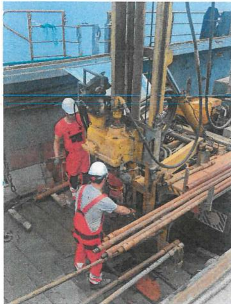
Сн. 1. Изпълнение на проучвателно сондиране от кораб в акваторията на пристанище „Бургас – Изток 2
