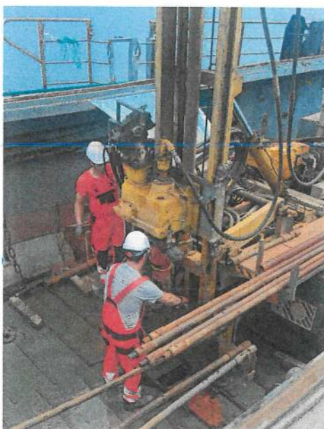
Сн. 1. Изпълнение на проучвателно сондиране от кораб в акваторията на пристанище „Бургас – Изток 2
